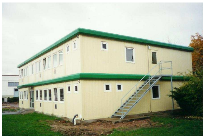
Beispiel einer Außentreppe mit kleinem Podest, Geländer und Stütze.
